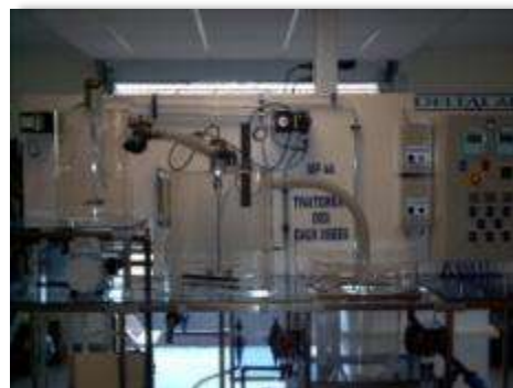
Traitement des eaux usées par boues activées
