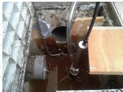
Fig 5 Installation d'un seuil triangulaire
