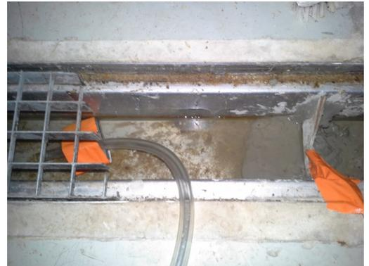
Fig 7 Seuil installé dans le caniveau central de la brasserie
